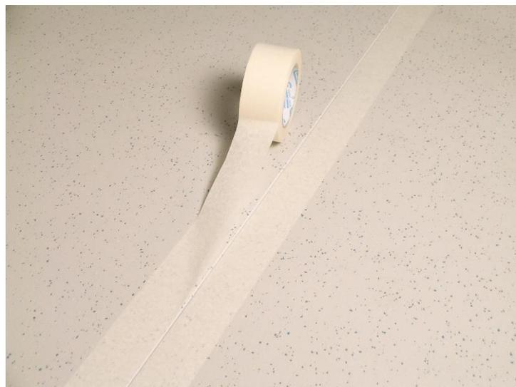
**2 – Proteggere i bordi del pavimento con nastro adesivo di carta resistente all'acqua**
